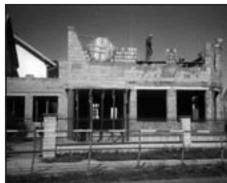
Prace przy rozbudowie Szkoły Podstawowej nr 2 przebiegają bardzo sprawnie
