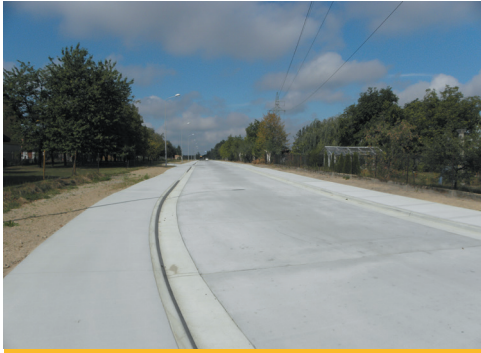
Pierwszy etap budowy Mościckiej i Słonecznej już zakończony
