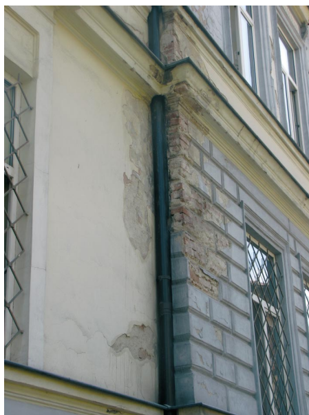
Budynek urzędu gminy prosił się o remont.
