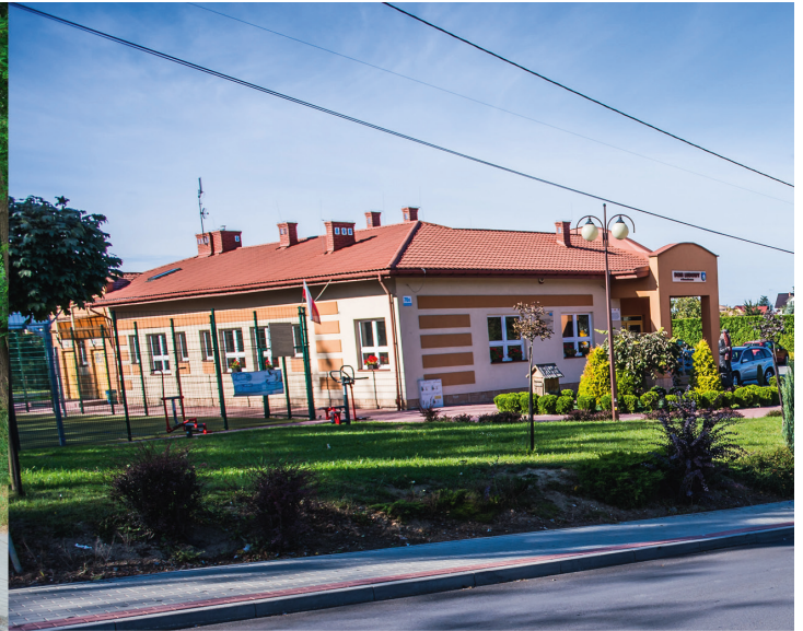
Wyremontowana droga i chodnik obok Domu Ludowego w Nowodworzu
