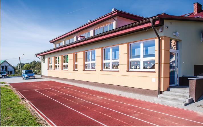
Dobudowana część przedszkolna przy szkole w Zawadzie
