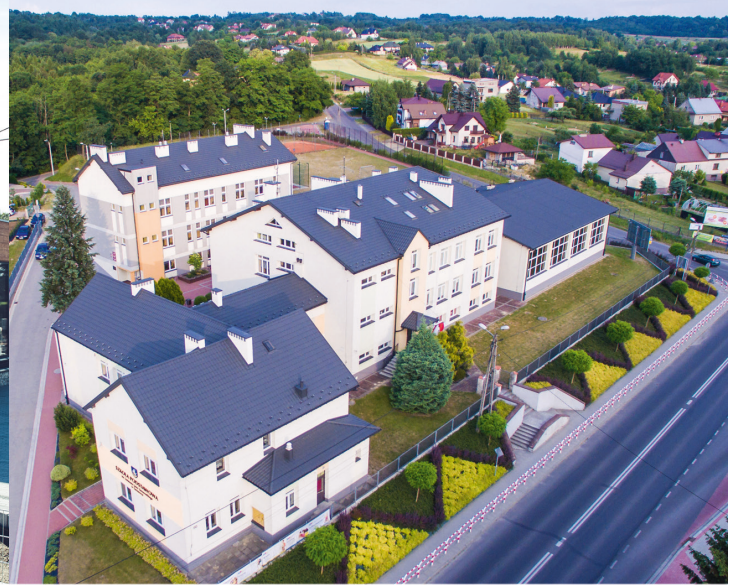
Szkoła w Tarnowcu z dobudowanym skrzydłem
