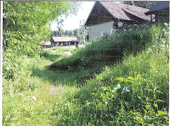
Pęknięcia dochodzące do zabudowań 11 A na posesji 698
