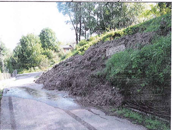
Jęzor osuwiska wchodzący na ul. Olszyny
