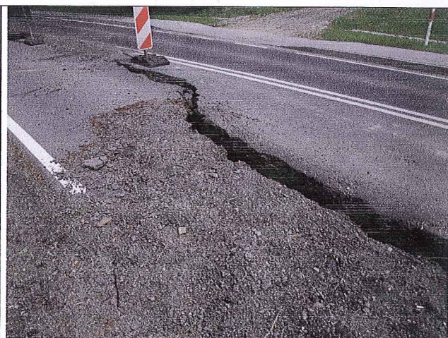
Centralna część skarpy głównej zlokalizowana pod koroną drogi woj. nr 997
