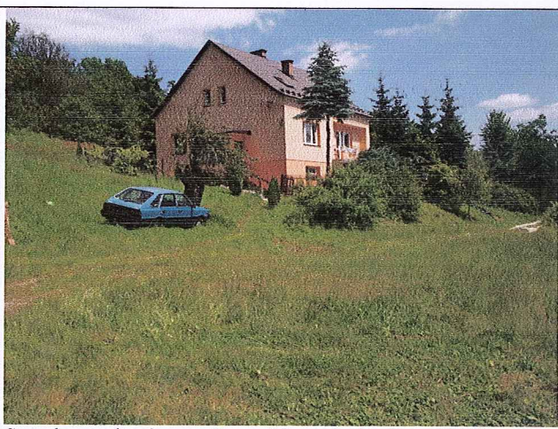
Centralna uruchomiona część osuwiska w obrębie dz. nr 49 i 50.
